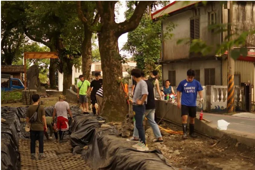
臺科大「行動工程師」移師至宜蘭東岳部落的東澳國小，建置生態渠道引水工程。
